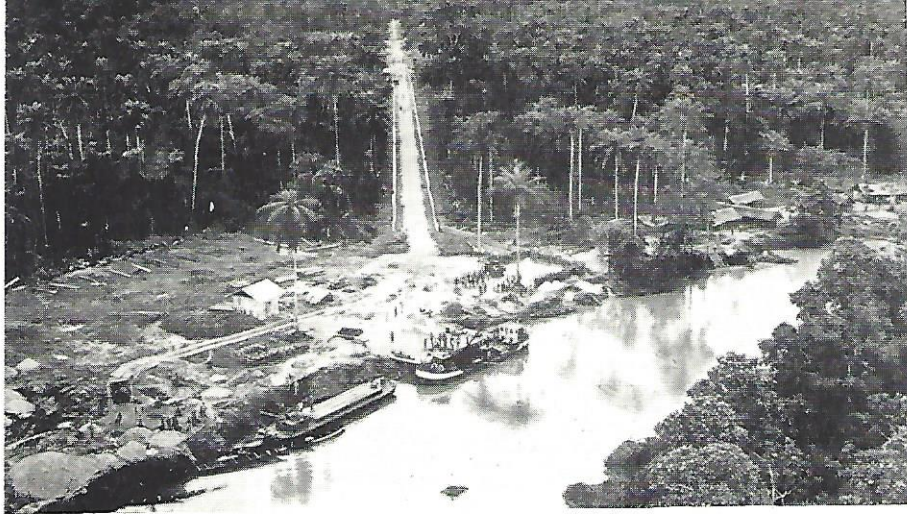
Een nieuwe locatie te Oloibiri, 110 km ten Zuid Westen van Owerri. De speciaal voor het transport van materiaal aangelegde weg is ongeveer 1 km lang.
