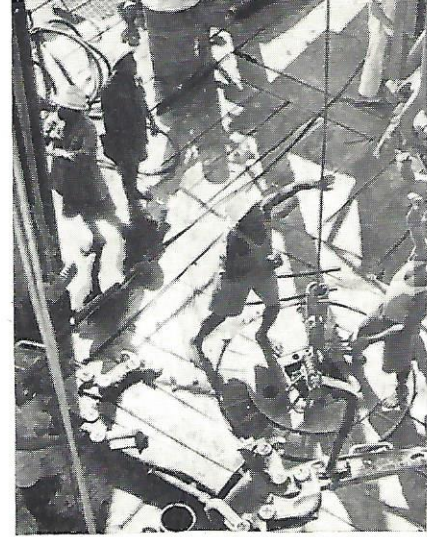
Het trekken van een pijpserie te Nzam.
